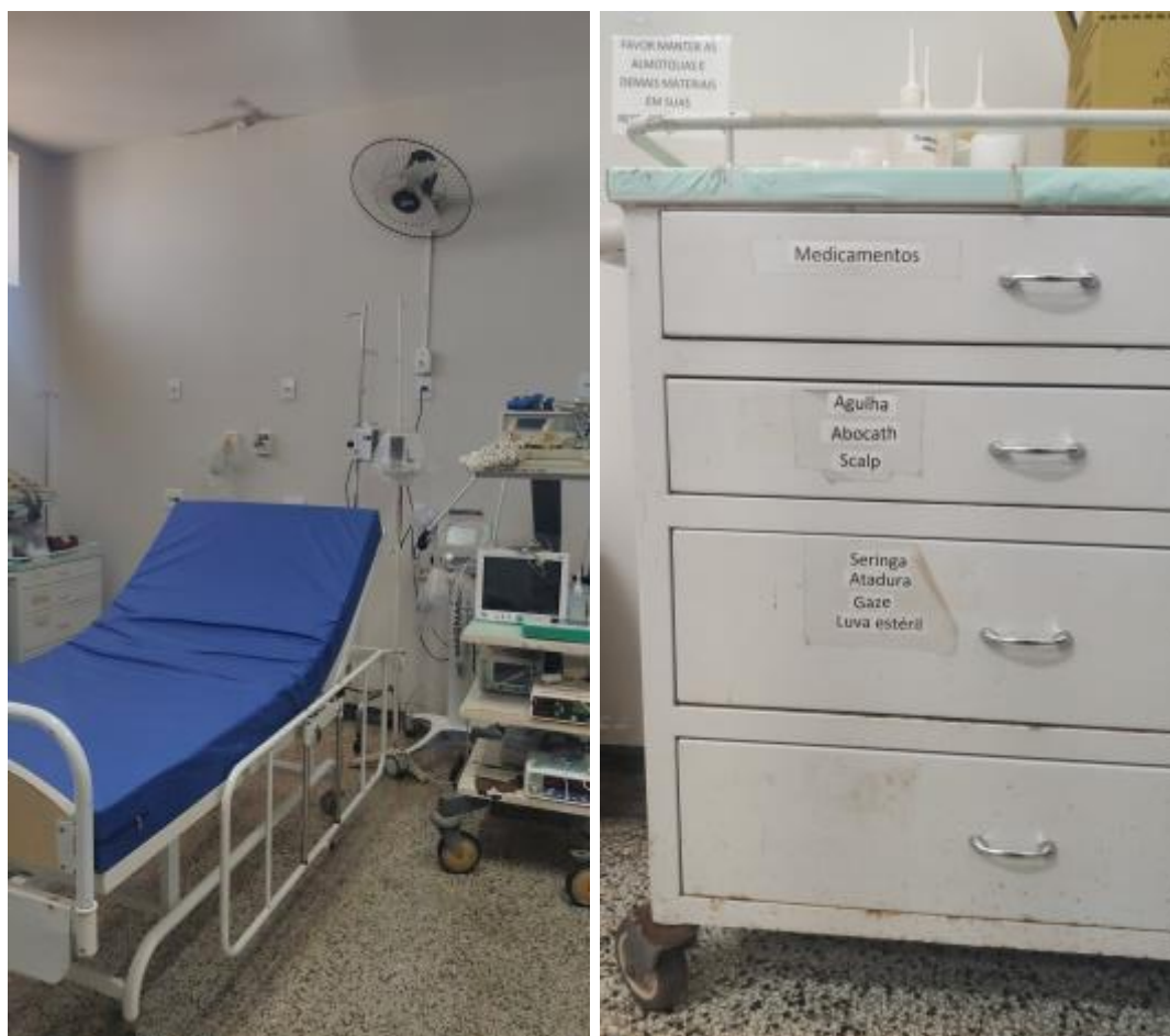
Bolor no teto da sala de emergência; armário enferrujado;
